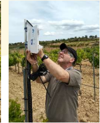
Instalación de un data logger en Gandesa el 6 de junio de 2019.
